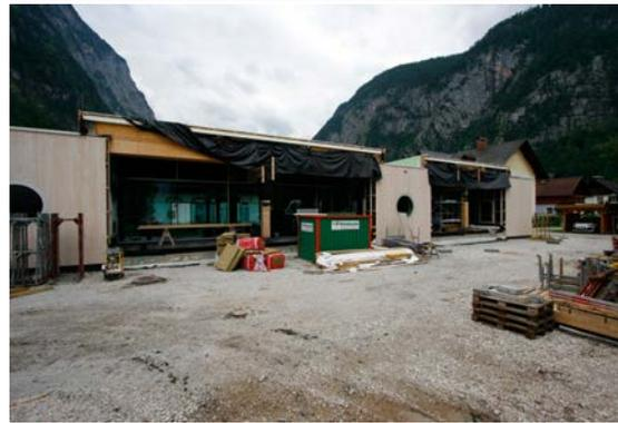
nach Abbruch eines historischen Salinengebäudes wurde der großflächige Trakt W4, der das Buffet, die Garderoben, einen Mehrzweckraum und Klassenräume enthält, errichtet. Sichtbeton, Gussasphaltpöden und Aufputzinstallationen bestimmen die Atmosphäre der Innenräume.
