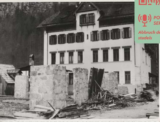
Als letztes wurden die steingemauerten Wandpfeiler des Stadels abgetragen. Das hochwertige, quaderförmig behauene Steinmaterial ist im Sockelmauerwerk des Südtrakts wiederverwendet.
