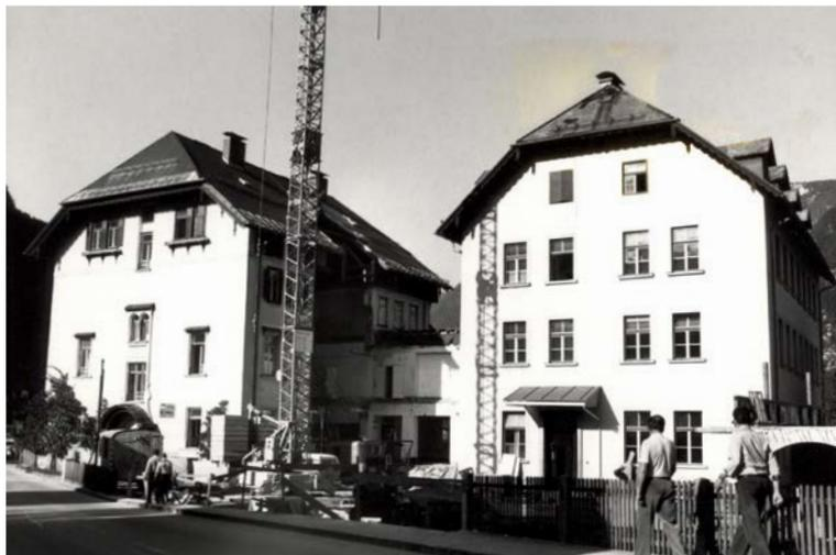
Der Verbindungsbau zwischen Nord- und Südtrakt wurde aufgestockt und damit ein weiterer Klassenraum gewonnen. Durch die Aufstellung des Dachs wurde auch im Dachgeschoß eine direkte Verbindung zwischen Nord- und Südtrakt möglich.
