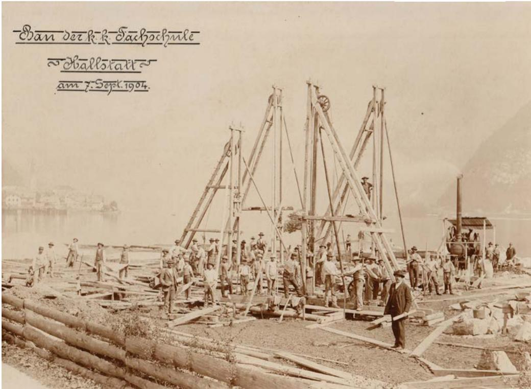
Der schwierige Baugrund am Schuttkegel der Waldbachmündung erforderte eine aufwändige Fundierung. Die Holzpfähle wurden mit Dampftrieb eingerammt. Bei genauer Betrachtung der Fotografie erschließen sich zahlreiche Details des Baustellenalltags zu Beginn des 20. Jahrhunderts.
