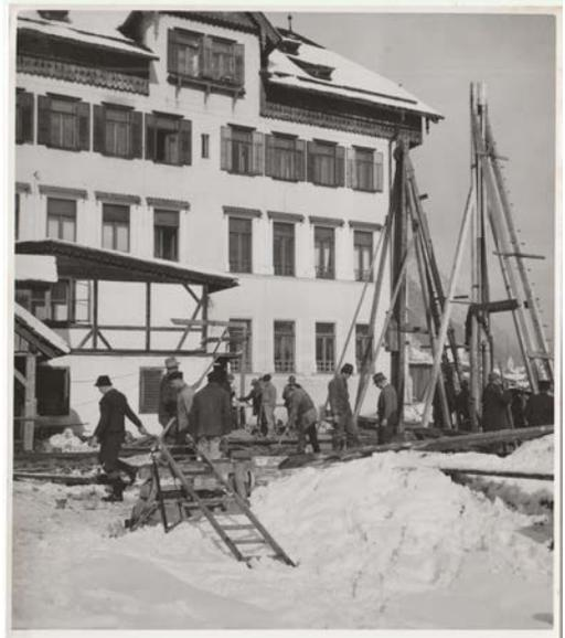
Auch unterhalb der Fundamente des Südtrakts wurden Holzpfähle (Piloten) in den instabilen Baugrund am Seeufer eingerammt. Die Rammgerüste scheinen mit denen von 1904 identisch zu sein und stammten wohl aus salinarischen Beständen.
