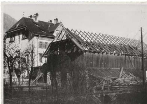
Der Dachstuhl war als Sparrendach mit einem Spitzboden über trapezförmigen Sprengwerksbindern ausgeführt, wodurch sich große, stützenfreie Innenräume ergaben. Diese Räume waren, auch durch ihre luftdurchlässigen Wände, hervorragend zur Lagerung und Manipulation großformatiger Schnittholzsortimente geeignet. Über den Strommast am rechten Bildrand wird bereits eine dreipolige Drehstromleitung geführt.
