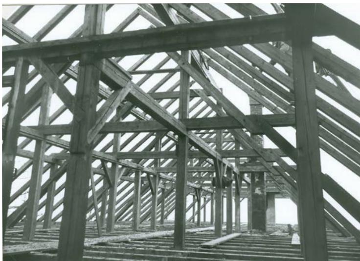
Vor allem der bereits in seiner ursprünglichen Konzeption als Schnitt-holz-lager angelegte und handwerklich hervor-ragend als Zimmerwerk ausgeführte dreigescho-ßige Dachraum hätte noch über Jahre genutzt werden können.
