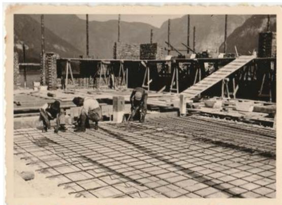
Im Laufe des 20. Jahrhunderts verdrängten betonierte Deckenkonstruktionen die traditionellen Holztrammeden. Waren beim Nordtrakt 1904/05 noch Holztrammeden Stand der Technik, so wurden 35 Jahre später beim Südtrakt bereits Eisenbetondecken eingebaut.
