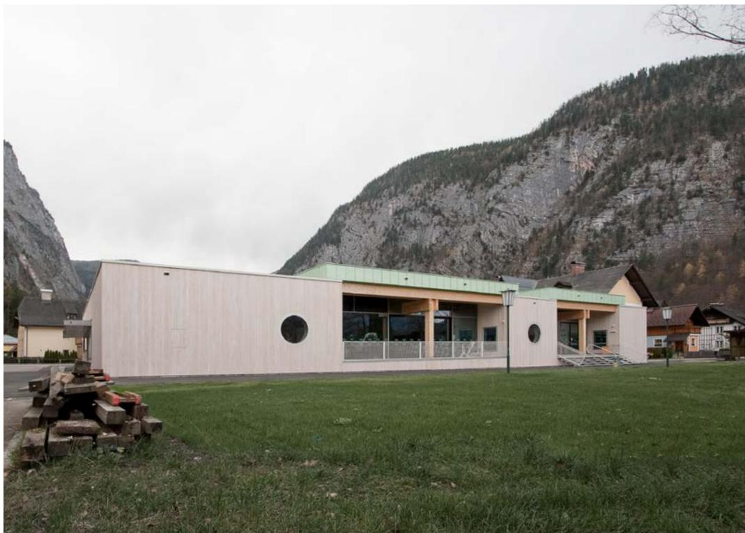
In der Ostfassade des Traktes W4 ist die Verglasung des zentralen Raumes und des Buffetbereichs zurückgesetzt, während die Holzkonstruktion der Decke die Glasebene durchdringt und so das Motiv der sperrenden zentralen Stützen auch in der Fassade abbildet.
